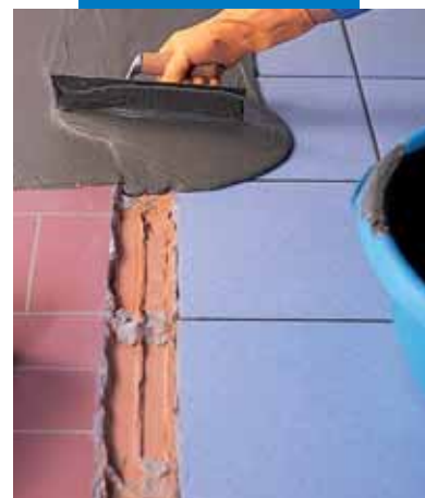
Bojātas grīdas izlīdzināšana ar Adesilex P4
