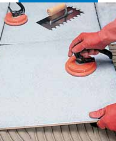
Liela izmēra flīžu instalēšana
