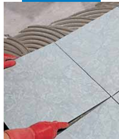
Porcelāna flīžu instalēšana
