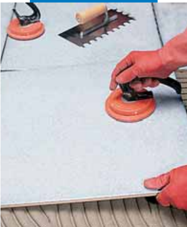
Liela izmēra flīžu instalēšana
