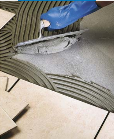
Flīžu instalēšana uz grīdām
