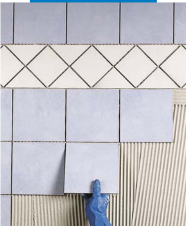
Flīžu instalēšana uz ģipškartona sienām
