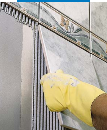
Flīžu instalēšana uz apmetām sienām
