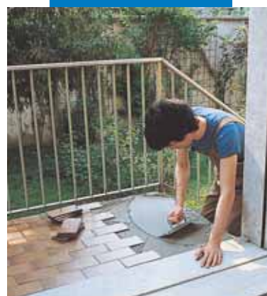
Hidroizolācijas uzklāšana un flīžu klājuma izveide, izmantojot Kerabond T + Isolastic
