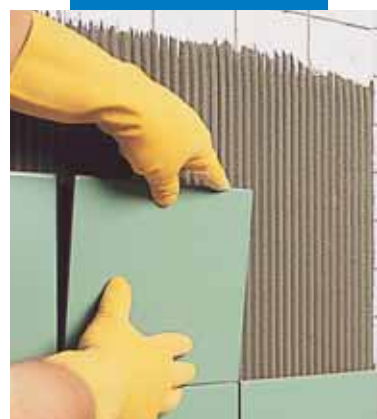
Flīžu instalēšana uz veca flīžu klājuma
