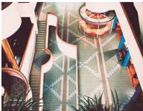
Porcelāna flīžu instalēšana, izmantojot Kerabond + Isolastic - Sabiedriskais centrs - North ork Ontario (Kanādā)
