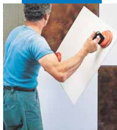
Akmens plākšņu instalēšana uz vertikālām virsmām
