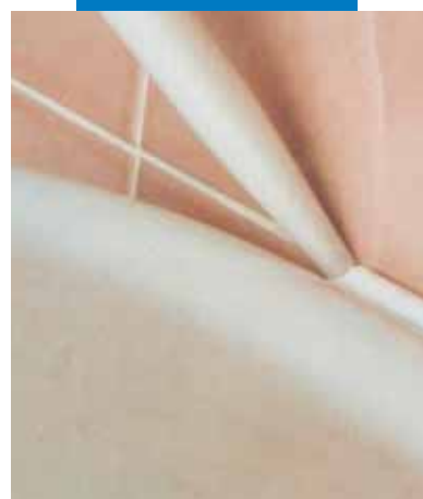
Šuvju hermetizēšana starp sanitārtehniskajiem izstrādājumiem un flīzētām virsmām
