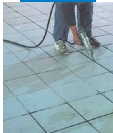
Keramisko flīžu klājuma šuvju aizpilde grīdām
