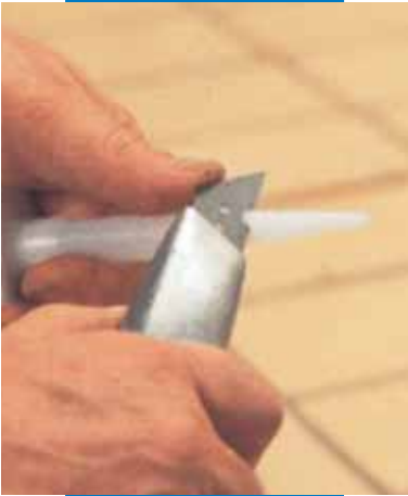
Uzgaļa nogriešana atbilstoši šuves izmēram
