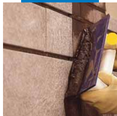
Ultracolor Plus uzklāšana uz vertikālām virsmām ar gumijas špaktelļapstiņu
