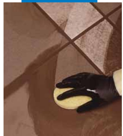
Virsmas tīrīšana un šuvju izlīdzināšana ar švammī
