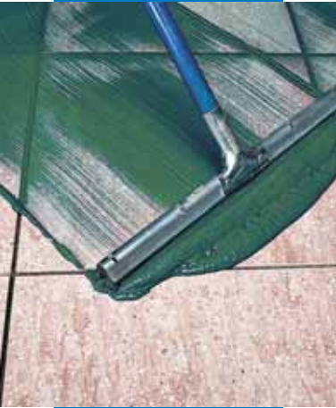
Uz grīdas Ultracolor Plus uzklāt ar šim nolūkam piemērotu instrumentu
