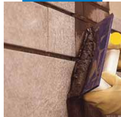
Ultracolor Plus uzklāšana uz vertikālām virsmām ar gumijas špaktelļapstiņu
