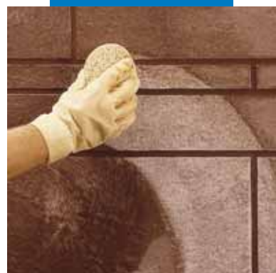
Virsmas tīrīšana un šuvju izlīdzināšana ar švammī
