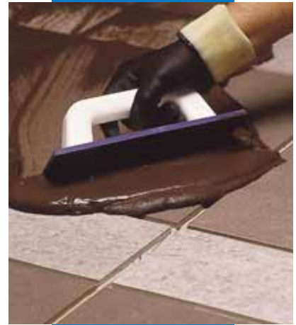
Ultracolor Plus uzklāšana uz grīdas ar gumijas špaktelļapstiņu
