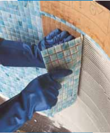
Stikla mozaikas (2x2 cm) pielīmēšana peldbaseinā ar Adesilex P10 līmjavu, kas sajaukta ar Isolastic - ūdens šķīdumu (attiecība 1:1)
