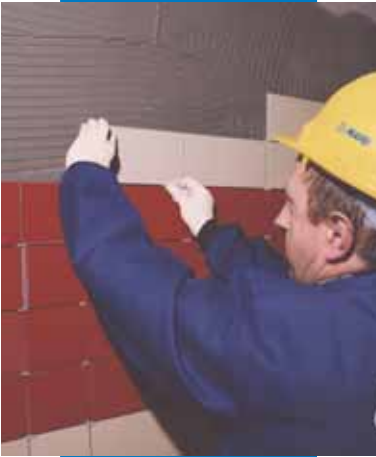
Polaganje keramičkih pločica za zid
