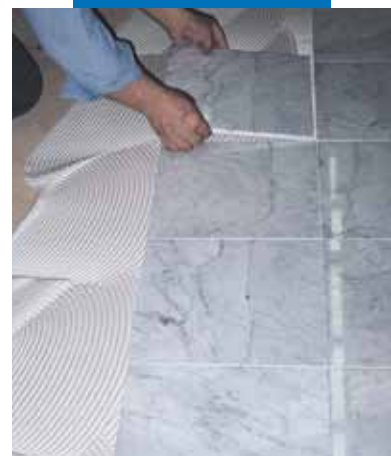
Carrara marmora plāksņu instalēšana uz koka pamatnes izmantojot Balto Keralastic
