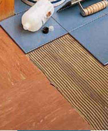
Klājuma izveide uz veca PVC grīdas seguma
